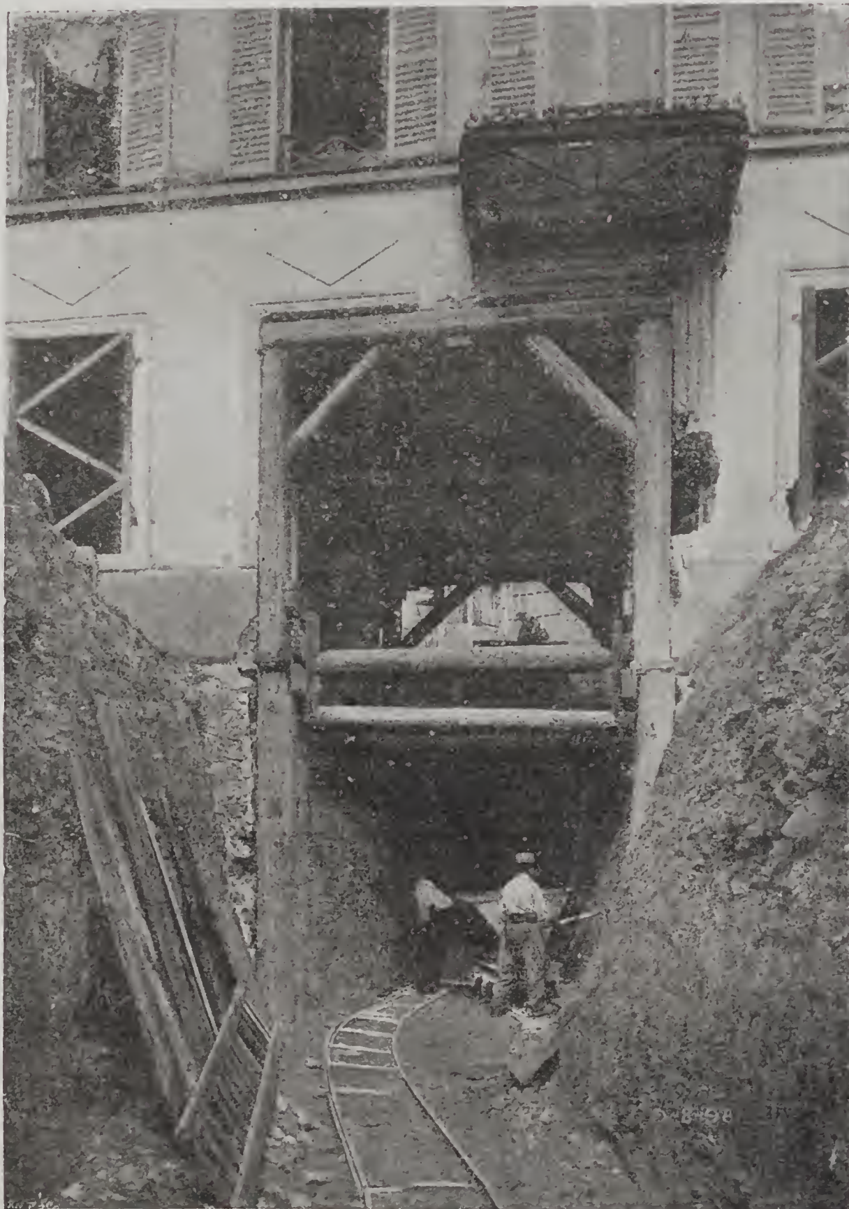
LA LIGNE COURCELLES-CHAMP-DE-MARS. Sortie du tunnel dans une maison, côté Champ-de-Mars.
